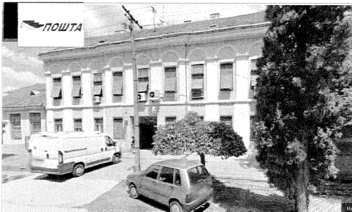
ФОТОГРАФИЈЕ ОБЈЕКТА ПОШТА 26348 БЕЛА ЦРКВА - Бели трг 11, Бела Црква УЛИЧНА ФАСАДА
