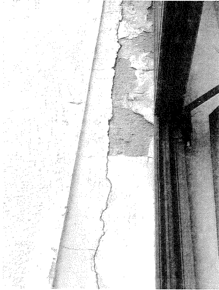
Детаљ фасаде око отвора
